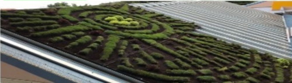
3 ème Etape: Installation des modules végétalisés et raccordement au système d'irrigation
